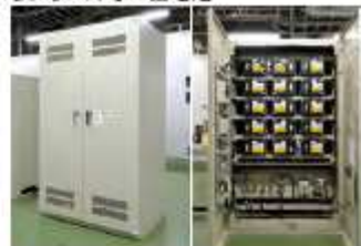
リチウムイオン蓄電池
